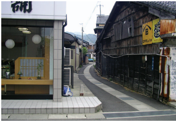
写真-1 尾鷲市の狭い道に面する古い建物
